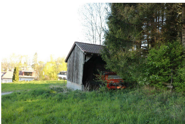
Im nördlichen Geltungsbereich befindet sich ein alter Holzschuppen, welcher aller Voraussicht nach erhalten bleibt.
