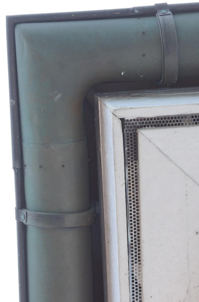
Gebäude Halle Nr. 5 Nordansicht und Geb. 2 und Spaltenquartiere im Bereich der Dachblenden.
