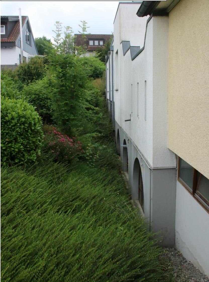
Gebäude Nr. 1 Ostfassade und Fläche Nord-Süd-Richtung mit Bodendecker, Sträucher u.a.
