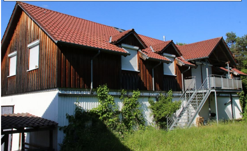
Gebäude Nr. 4 Südansicht und Gehölze Grenze Plangebiet Süd.
