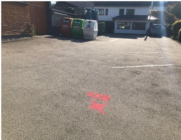
Abb. 3: Flurstück 2001/13 am Bohrpunkt BK 3/21 mit Blick in südlicher Richtung
