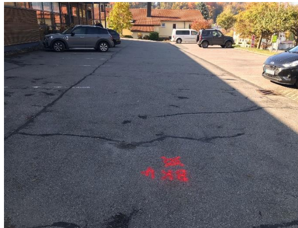
Abb. 4: Flurstück 2001/13 am Bohrpunkt BK 4/21 mit Blick in westlicher Richtung
