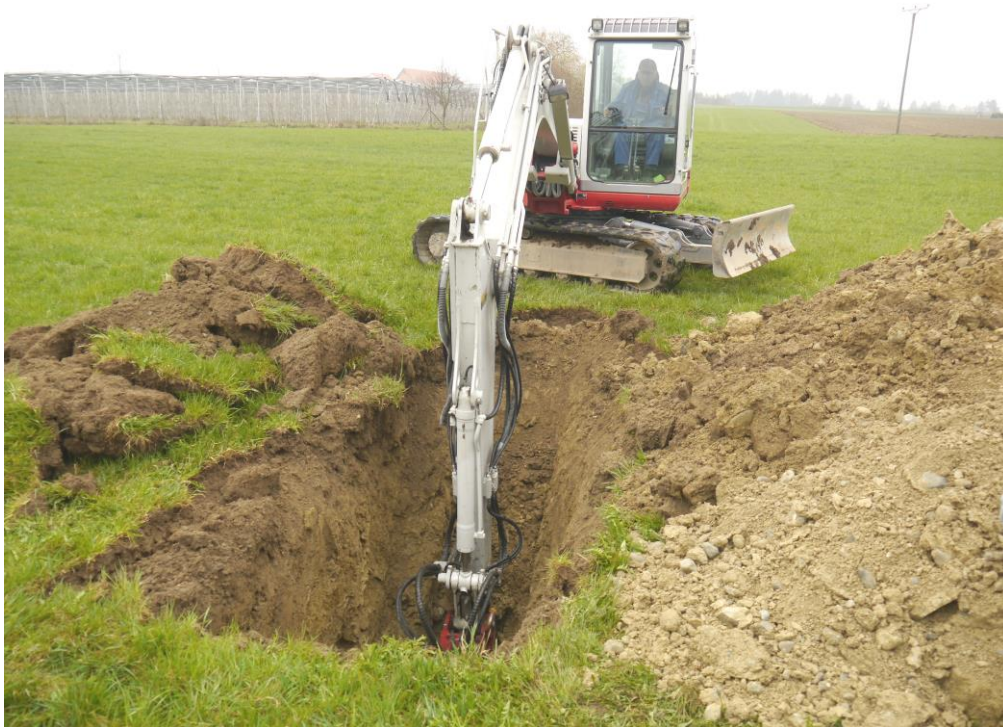
Abb.3: Herstellung Schurfgrube SG 2/14, Brachwiese, Schmalegg
