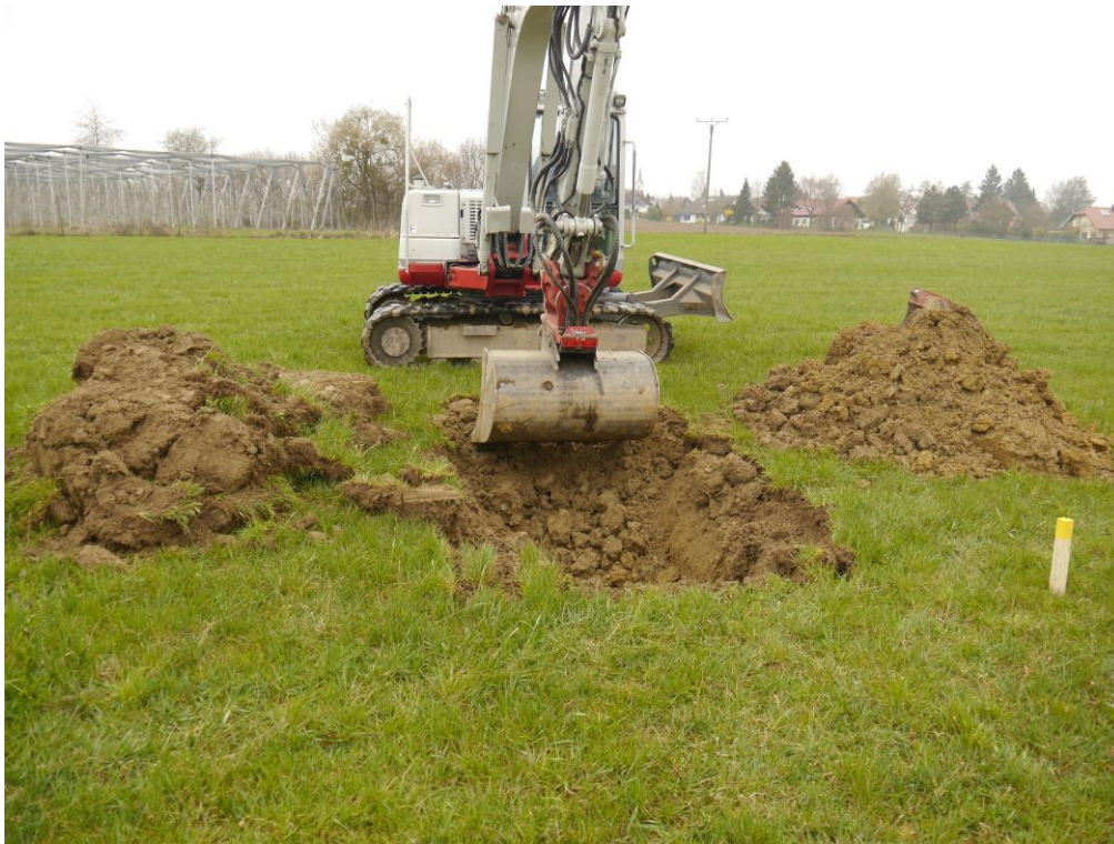
Abb.1: Herstellung Schurfgrube SG 1/14, Brachwiese, Schmalegg
