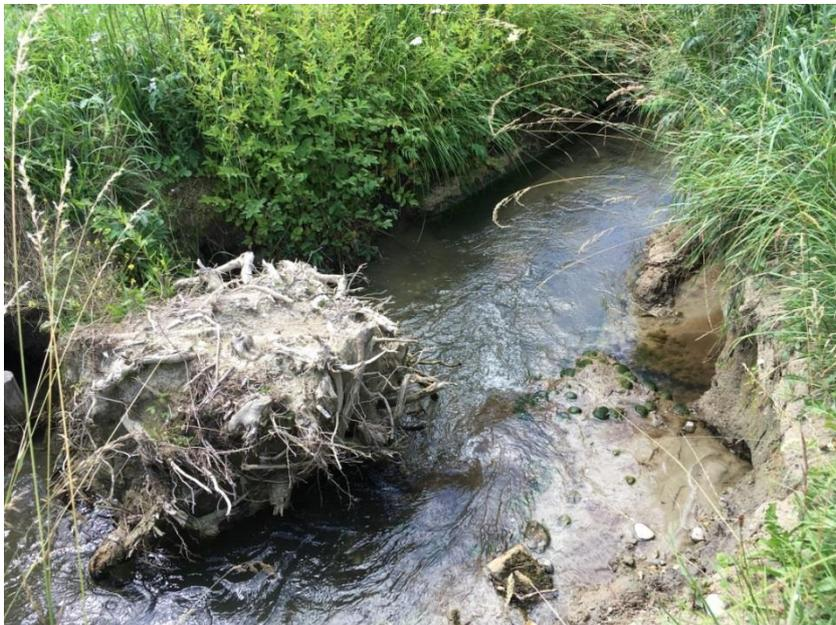
Abbildung 2: Einbaubeispiel Buhne am Längenbach in ÜB-Nesselwangen
