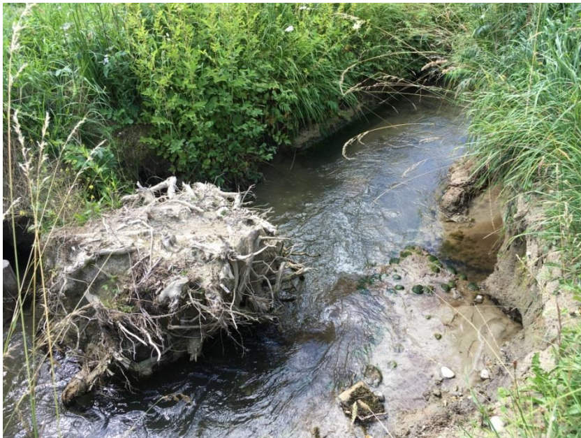
Abbildung 2: Einbaubeispiel Bühne am Längenbach in ÜB-Nesselwangen
