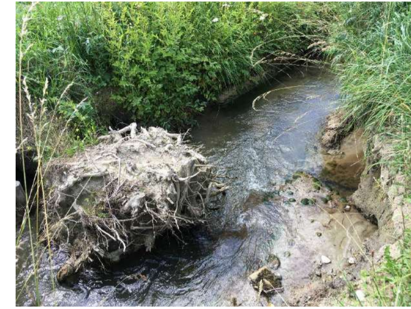
Einbaubeispiel Baumstammuhne
