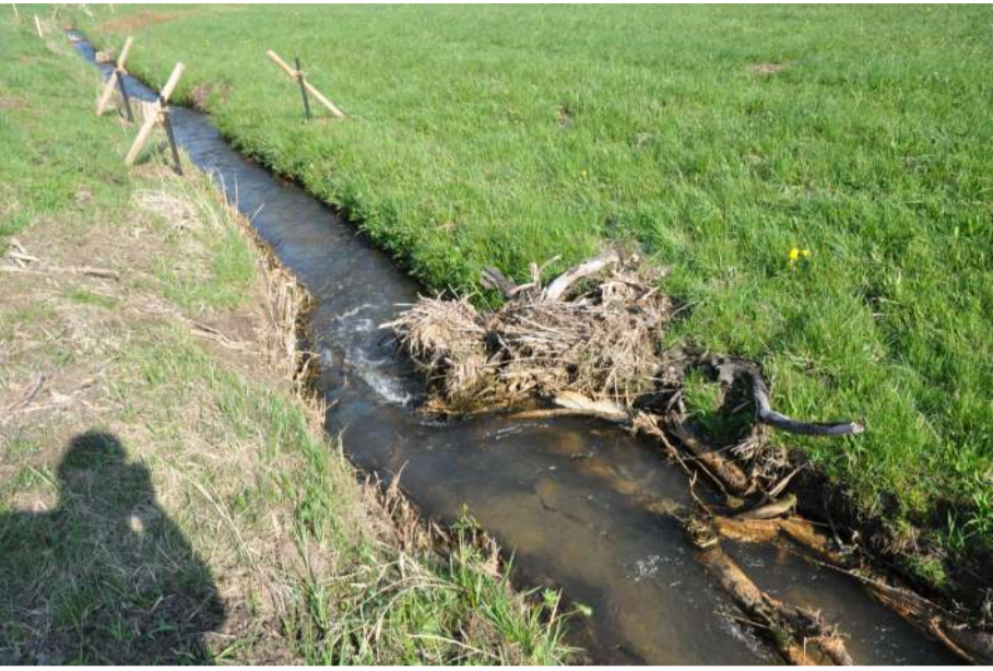
Einbaubeispiel Wurzelstock
