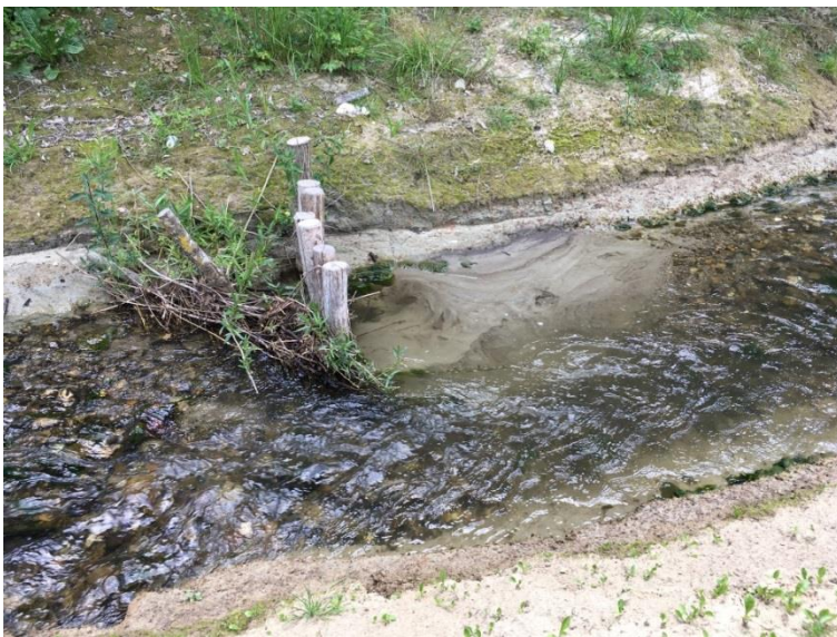
Abbildung 8: Einbaubeispiel am Langenbach ÜB-Nesselwangen
