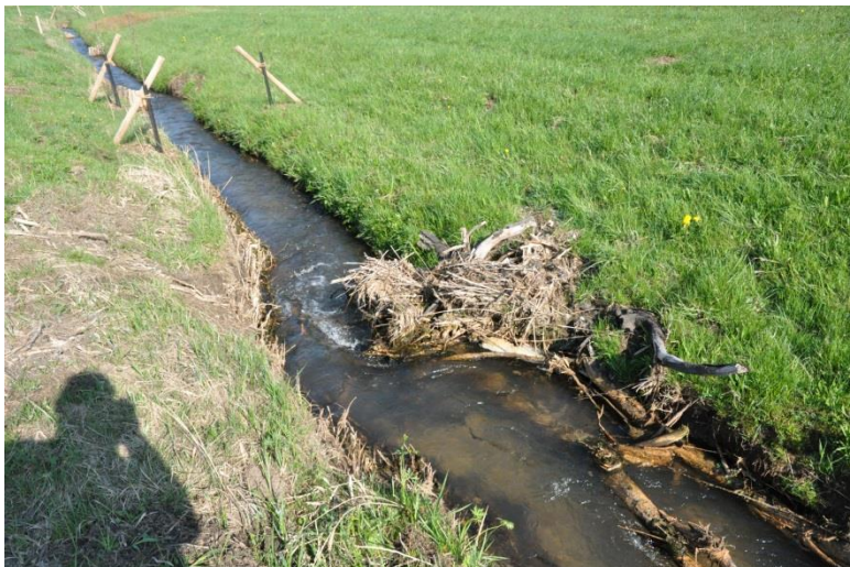
Abbildung 6: Einbaubeispiel Wurzelstock am Langenbach in ÜB-Nesselwangen
