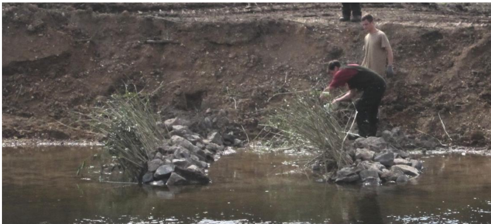
Abb. 11: Einbau von Buschbautraversen an der Donau in Donaueschingen, hier allerdings mit Weiden.
